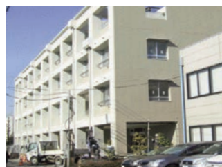
厚木看護専門学校建替工事
