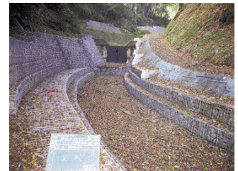
棚沢「一い沢」砂防工事
