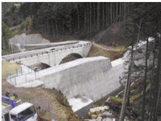
七沢「山の神沢」砂防工事
