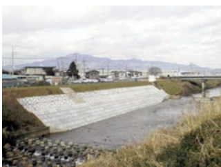
玉川酒井地区護岸工事
