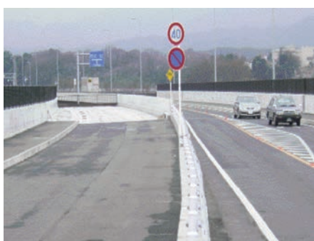
4車線化工事(左)が進む中津川大橋
