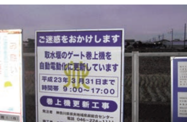
ゲート巻き上げ機の設置現場
