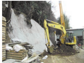
山際地区急傾斜地対策事業
