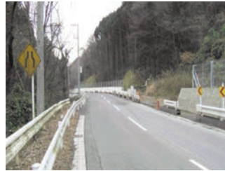
県道伊勢原津久井線七沢バイパス工事
