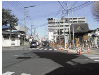
相模原大磯線荻野新宿交差点改良工事
