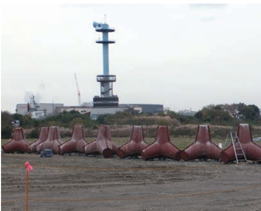
護岸を守るテトラポッドの工事(三川合流点)
