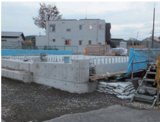
県道相模原大磯線・恩曾川のハツ橋架け替え工事
