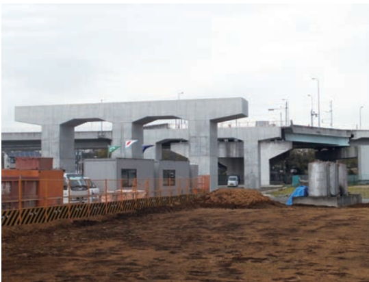
橋梁整備が進む座間荻野線の第2期工事
