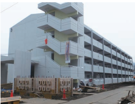
第3期の本体工事が完了した緑ヶ丘団地
